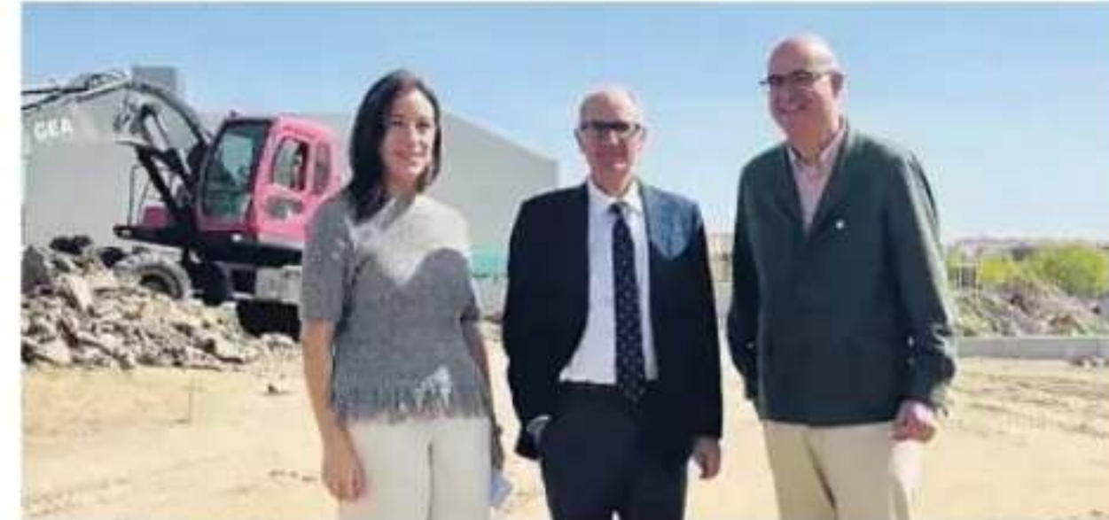
Javier Iglesias, junto a la diputada Pilar Sánchez, visita las obras
